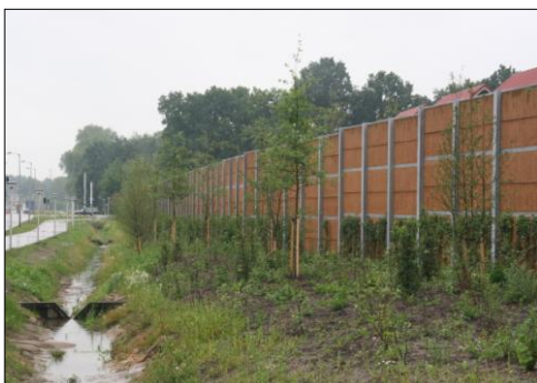
Kokowall geluidsscherm te Enschede, l=200m 5m hoogte.
