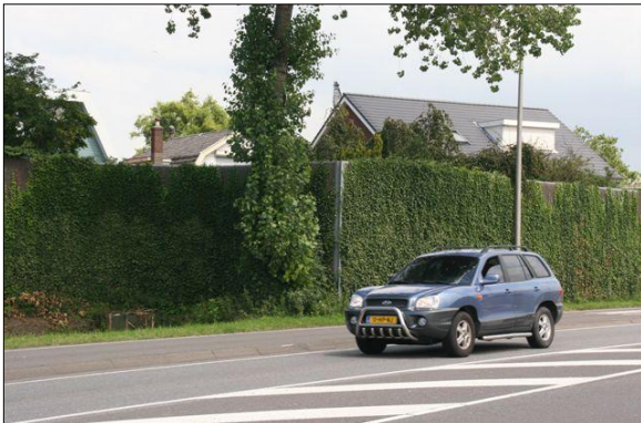
Kokowall geluidsscherm te De Lier 4m hoogte: met Hedera Hibernica plant binnen 3 jaar volledig begroeid!
