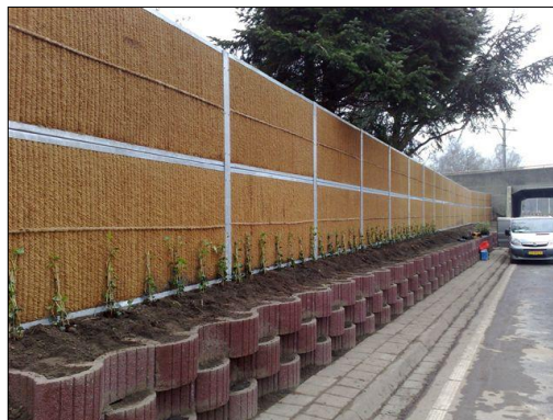
Kokowall geluidsschermb te Weert H=3m, l=50m
