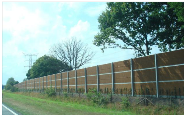
Geluidsscherm te Enschede N35, lengte 480m, 4,5m
