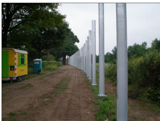
Montage en stellen bovenstijlen
