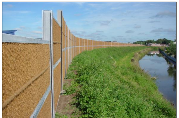
Kokowall geluidsscherm 2,5m hoogte, lengte 455m te Barneveld
