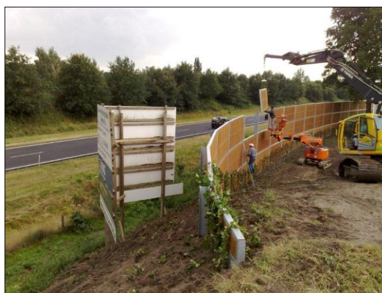
Inhangen en afmonteren panelen
