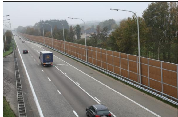
Kokowall geluidsscherm 3,5 - 5m hoogte, lengte 876m te Heusden-Zolder (BE)
