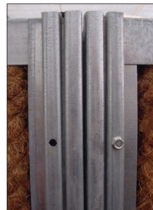
Foto: voorboren palen in buitenste profiel.
