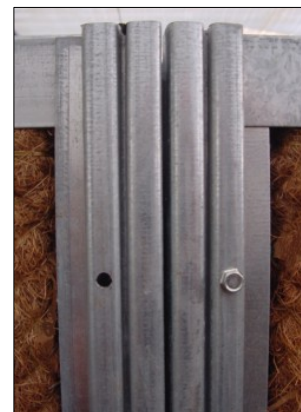
Foto: voorbereide palen in buitenste profiel.
