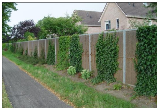
Kokowall geluidsscherm te Bommel, l=70m, 2m. hoogte Gezamenlijk aangeschaft door 5 bureu
