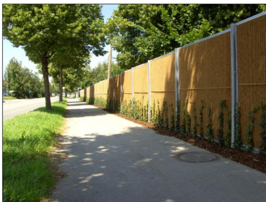
Kokowall geluidsscherm te Murnau (DE), 70m lang / 2m hoogte
