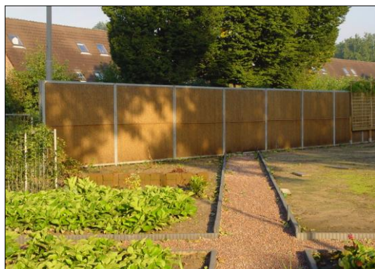
Kokowall geluidsscherm te Huissen, l=35m, 2m hoogte
